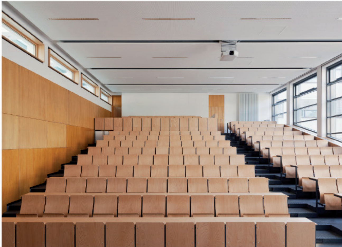
8 Kontraste: Alt und Neu, rauer Sichtbeton und glatte Gipskartonde- ckenflächen tragen zu einem harmonischen Gesamtbild bei. — Contrasts: old and new, rough exposed con- crete and smooth dry lining ceilings add up to a coherent harmonic appearance.
