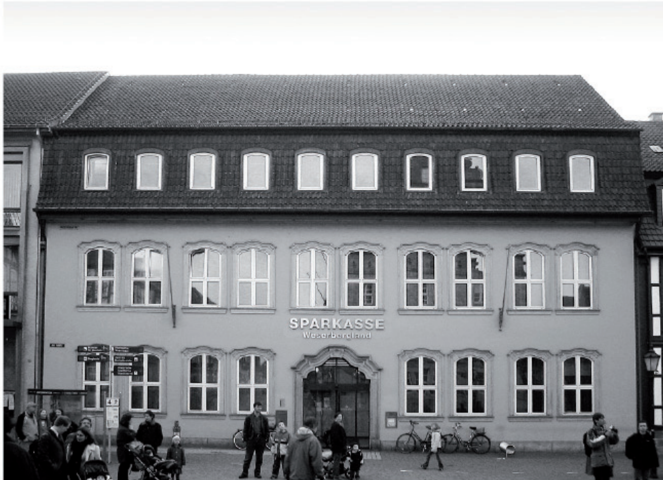
16 Blick vom Marktplatz auf die unanierte Sparkassenfassade — View from the market square towards the unaltered façade of the Sparkasse
