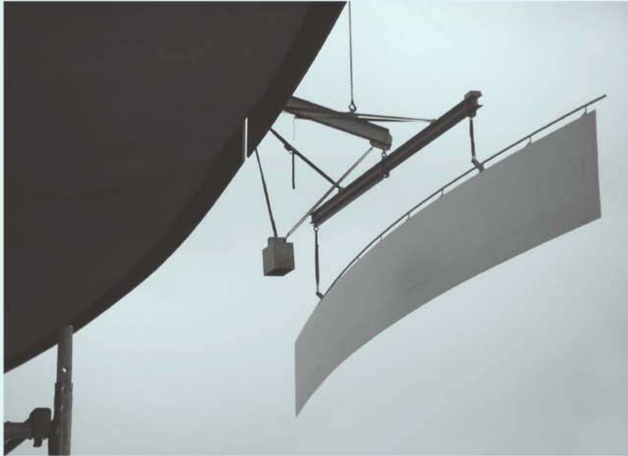
15 Hebevorrichtung mit 12 m langer Massiv- stahlbrüstung der Außenrampe — Special lifting device with 12 m long massive steel parapet-element for the outer ramp
