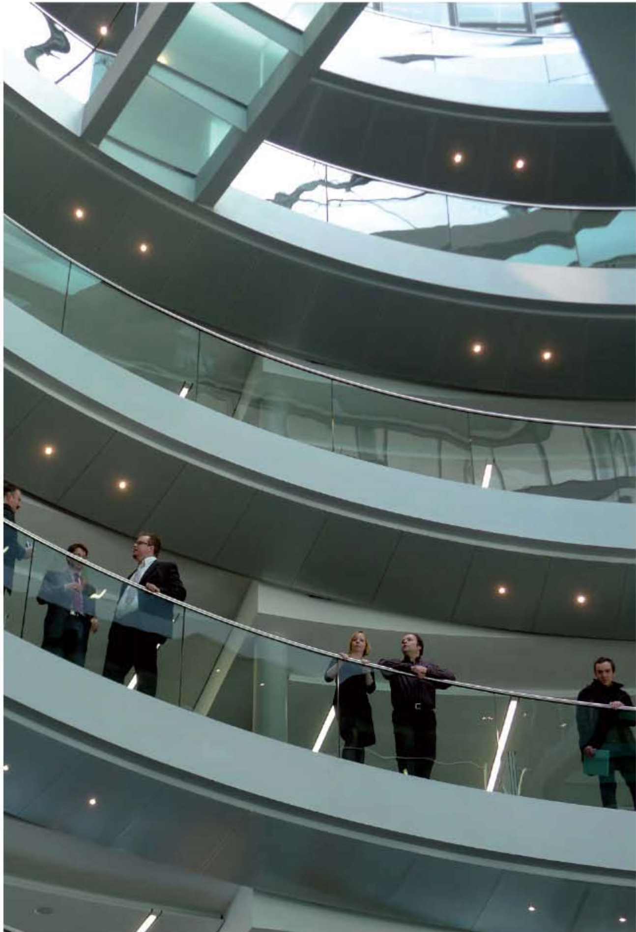
Akustikpanele mit integrierter Beleuchtung und Sprinklerung — Acoustic panels with integrated lightings and sprinklers
