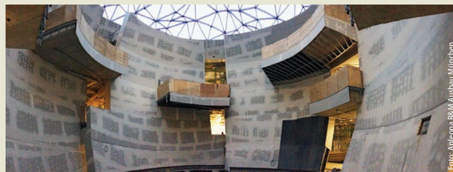
„Gestoßene“ Fugen. Im „Luftkernbereich“ trat die Problematik der Fugen noch stärker zutage, denn aufgrund der Fototapete durfte die Trennung nur noch bei sehr genauem Hinsehen erkennbar sein.
